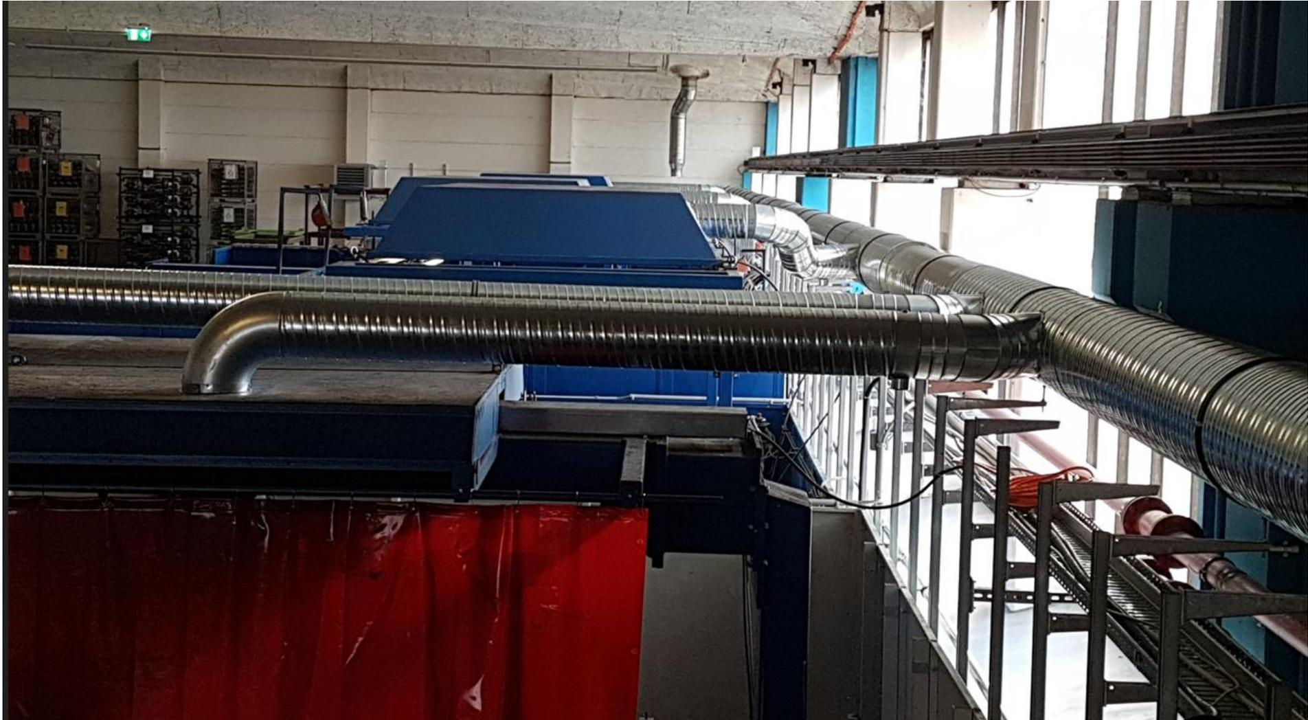
Wickelfalzrohrleitung D500 an einer Schweißroboterabsaugung
