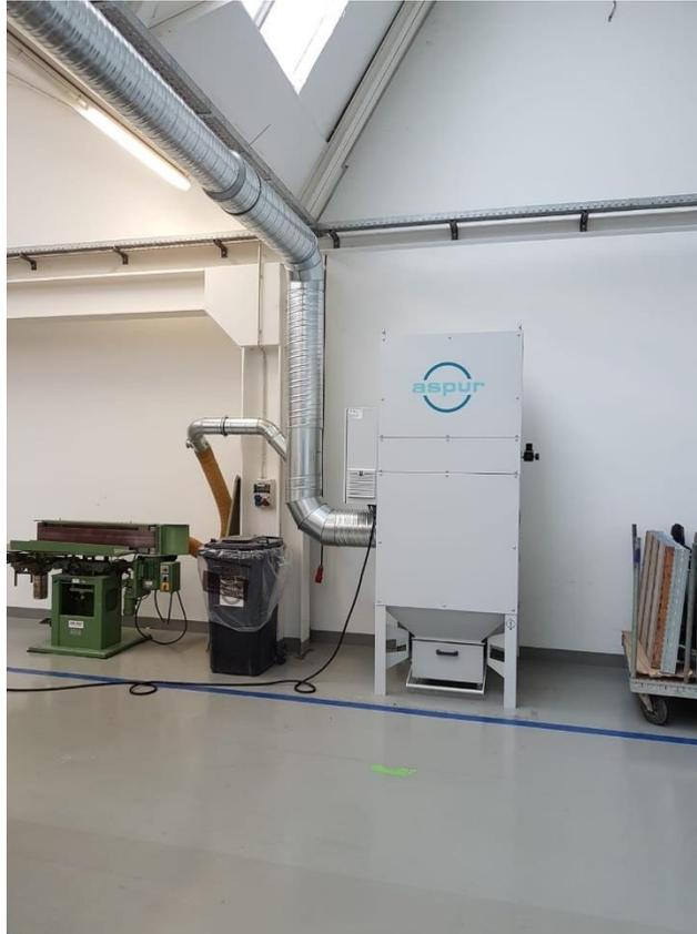
**Aluminiumspäne- Absaugung aero4 mit Zellenradschleuße und Entsorgungsbehälter**
